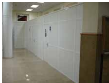
Obras en el vestíbulo de entrada.
