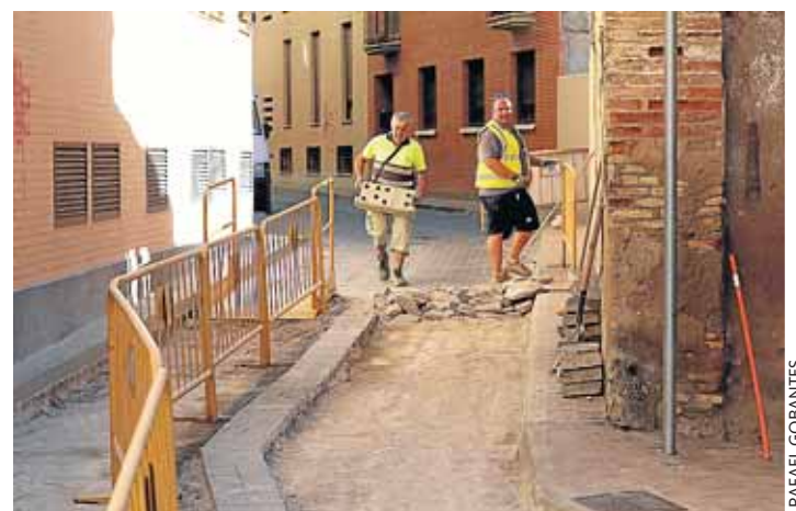
Los trabajos en la calle Pedro IV ya comenzaron en el tramo más próximo a la costanilla de Sellán.
