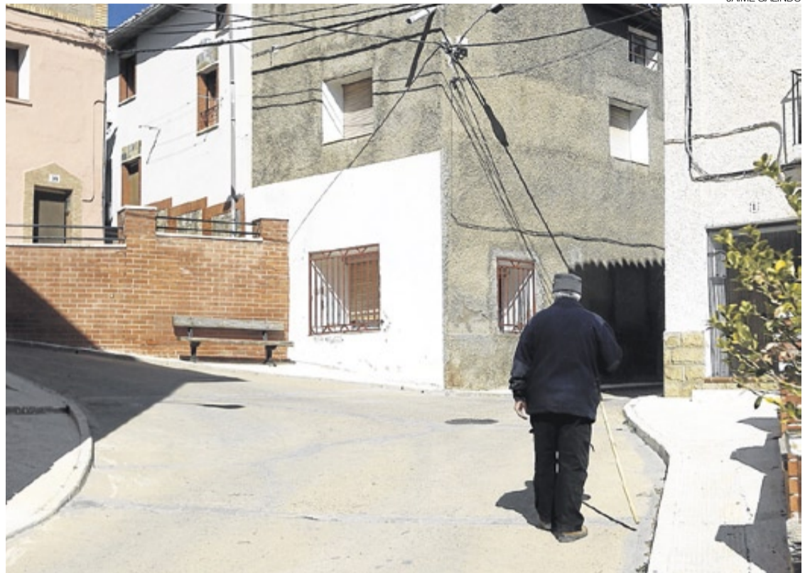
► La despoblación suele traer aparejada una degradación del estado de conservación de las viviendas.
