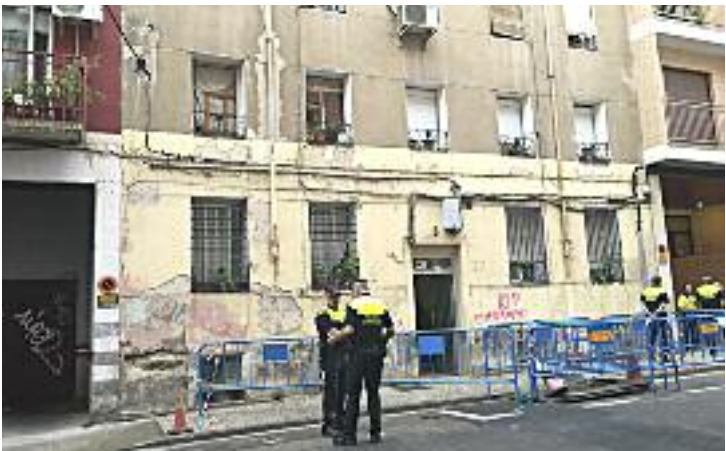
Imagen del edificio afectado. Aragón Press
